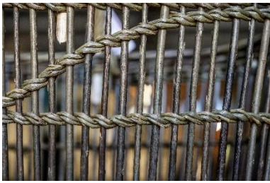
Figure 108- Clôture avec trace.
