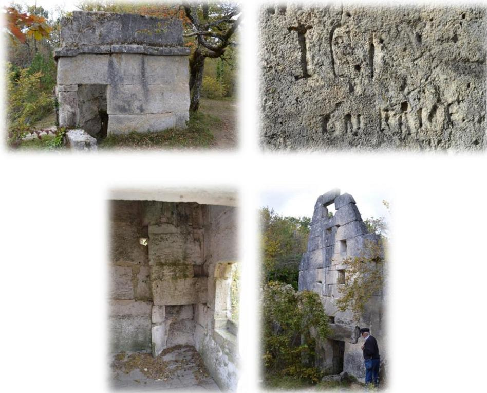
*Site de la carrière du Vieux Breuil : Partie supérieure d'un bâtiment bâti à l'aplomb d'un front de taille – À droite de l'entrée, on peut lire gravé dans la pierre : « ICI ON PRISE » - Cheminée dans la pièce intérieure - Bâtiment imposant, appelé « la chapelle » ; les murs du fond et latéraux ont été préservés dans la masse lors de la taille, le mur de façade a été bâti.(J.-J. Jarrige)*
