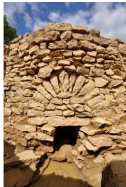
Passage d'une canalisation sous le temple principal.
