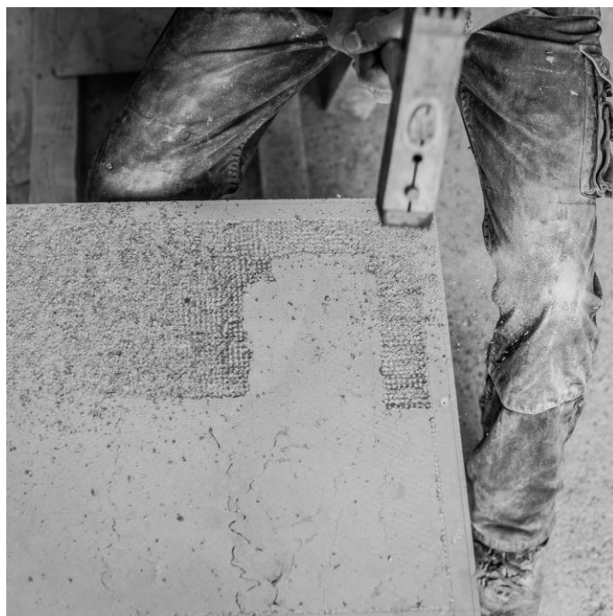
Fig. 44 : Opération de bouchardage.
