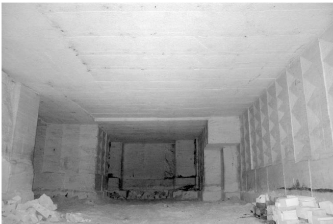
Une salle de la carrière Doumen, Léguillac-de-Cercles (Source : G. Duverneuil)
