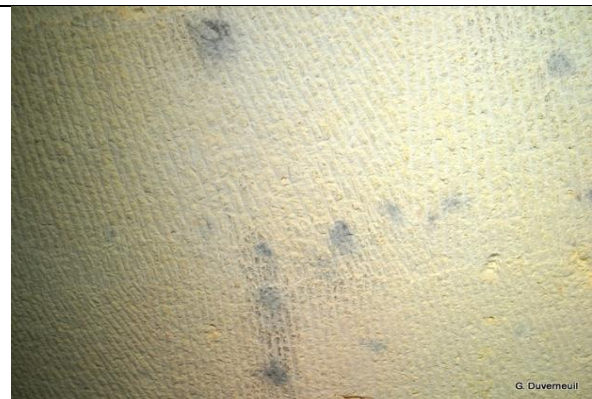
Traces de barre à chamber et de scie crocodile, galerie carrière Doumen, Léguillac-de-Cercles (Source : G. Duverneuil)
