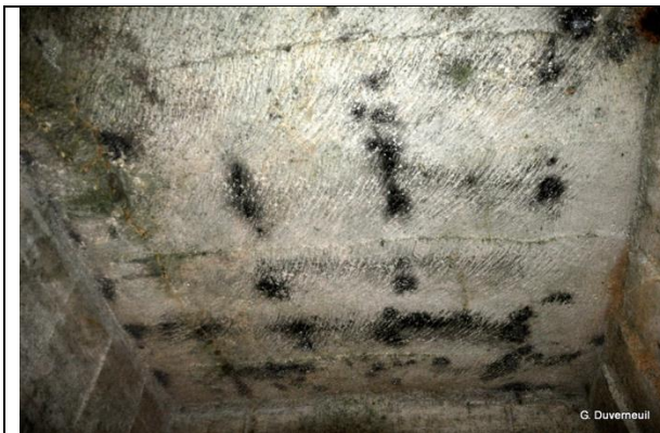
Traces d'usage de la piche au plafond d'une galerie de la carrière Doumen, Léguillac-de-Cercles (Source : G. Duverneuil)
