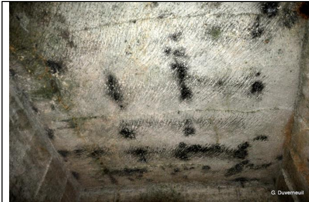
Trace d'usage de la piche au plafond d'une galerie de la carrière Doumen, Léguillac-de-Cercles (Source : G. Duverneuil)
