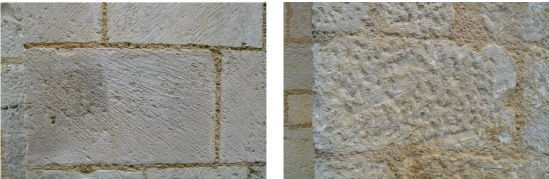
Pierres de parements striées et percutees par les outils de taille, visibles dans l'appareillage du mur sud de l'église de Limeyrat, XI e -XII e siècles. (Source : J.-J. Jarrige)
