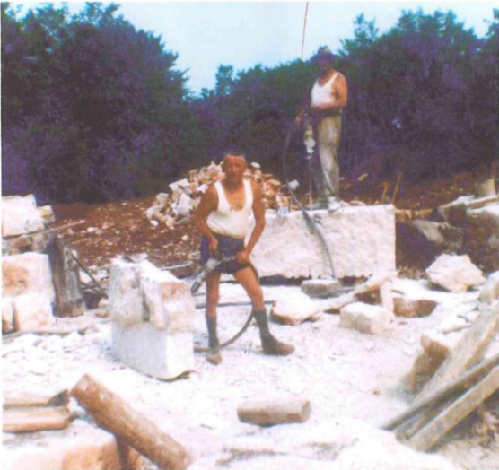
Années 1970 : apparition de la mécanisation dans Les travaux d'extraction et équarrissage de blocs dans la carrière de Limeyrat. (Source : Les Pierres du Périgord)
