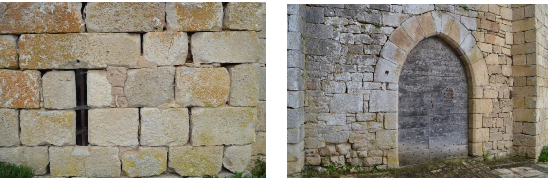
Château d'Ajat (XIV e – XVII e siècles) : détail de l'appareillage des pierres des murs montrant des hauteurs d'assises variables, une pose en joints décalés et par endroits des stries d'outils de taille. Entourage de porte réalisé avec des blocs taillés à façon. (Source : J.-J. Jarrige)
