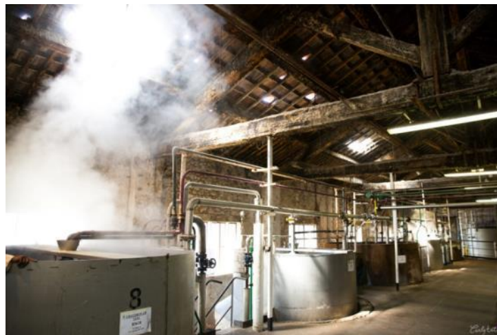
Salle des chaudrons d'une savonnerie marseillaise (Fer à cheval), 21 ème siècle
