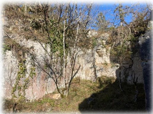
Fronts de taille dans la carrière à ciel ouvert du Vieux Breuilh (Photo J.-J. Jarrige)
