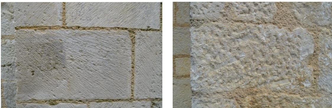
Pierres de parements striées et percutées par les outils de taille, visibles dans l'appareillage du mur sud de l'église de Limeyrat, XI e -XII e siècles. (Source : J.-J. Jarrige)
