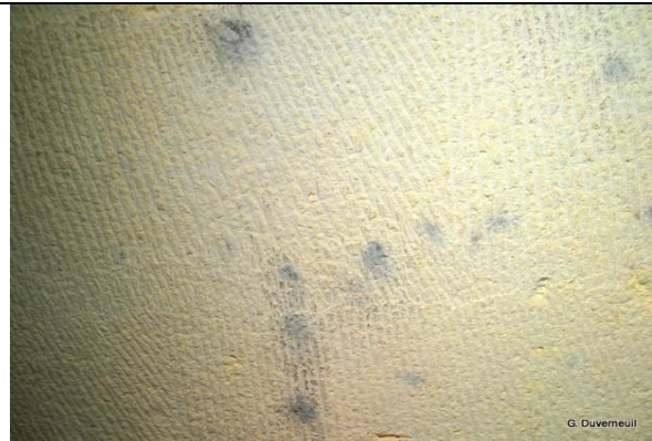
Traces de barre à chamberer et de scie crocodile, galerie carrière Doumen, Léguillac-de-Cercles (Source : G. Duverneuil)
